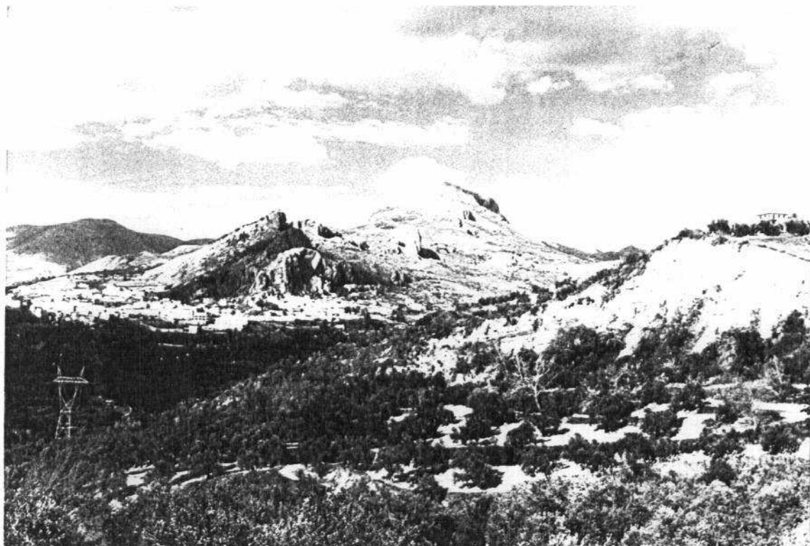
FOTO N°1 Vista general del pueblo de Cogollos Vega, sobre un deslizamiento, importante y problemas de desprendimientos de roca.
