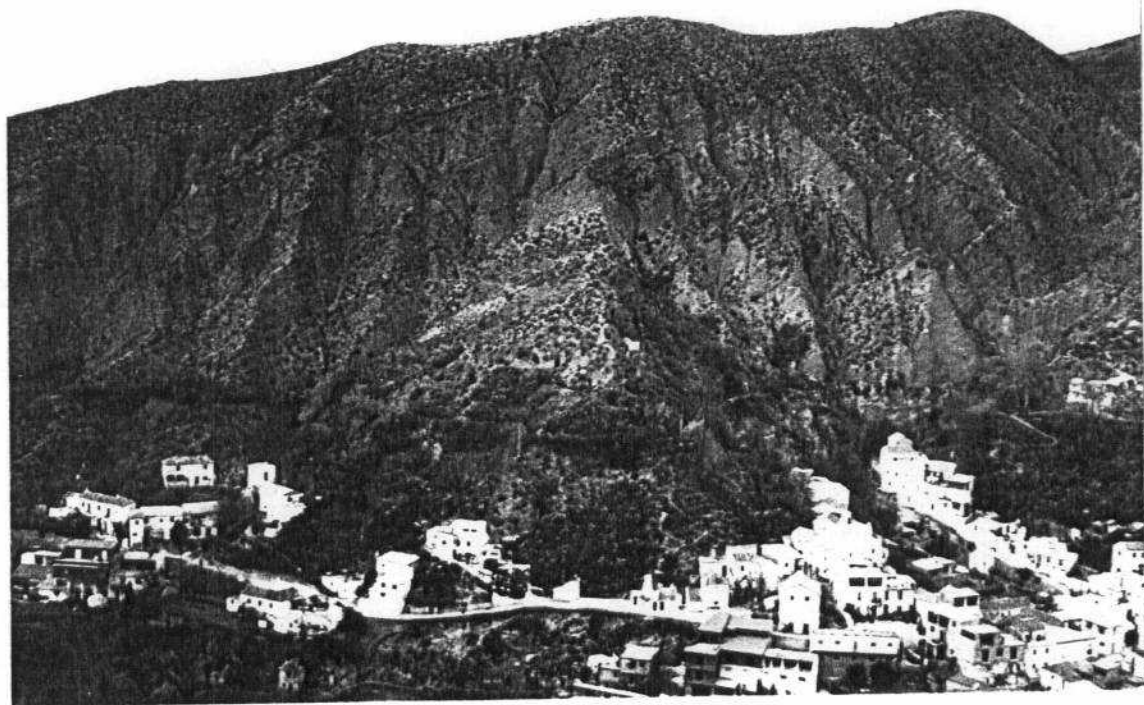
FOTO Nº2 Escarpes del sector B. En primer término gran bloque deslizado, encima de las casas.
